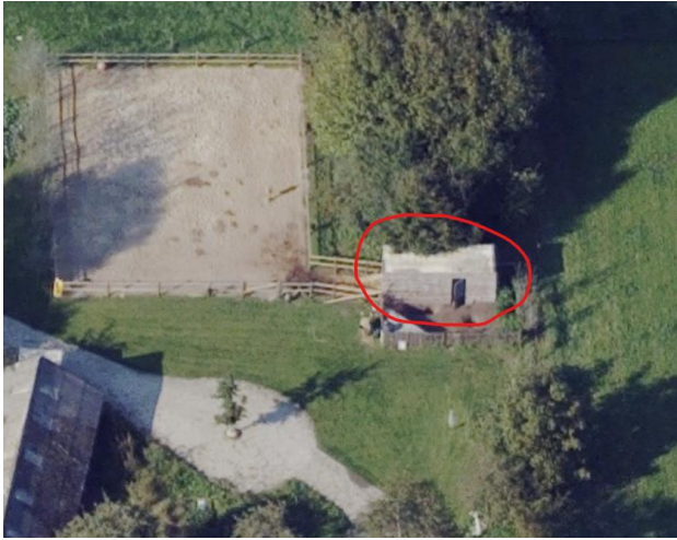
Te slopen schuur bij paardenbak (rood omlijnd)
