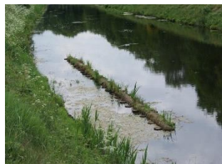
Detail kokosrol principeprofiel A en enkele praktijkvoorbeelden van het toepassen van oevermatten of -rollen
