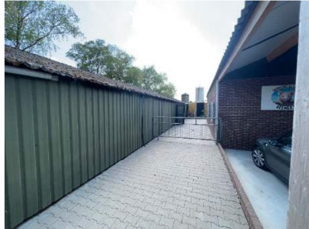
Figuur 10: Verharde afwateringszone
