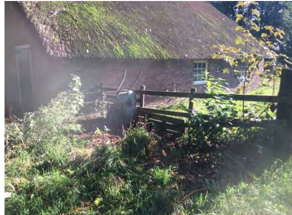
Figuur 9: Overzichtsfoto bebouwing
