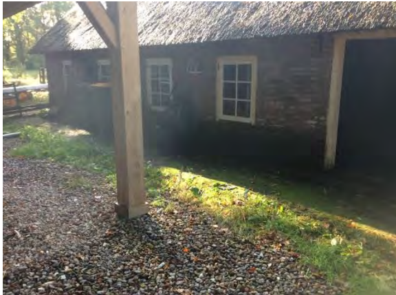
Figuur 8: Overzichtsfoto bebouwing
