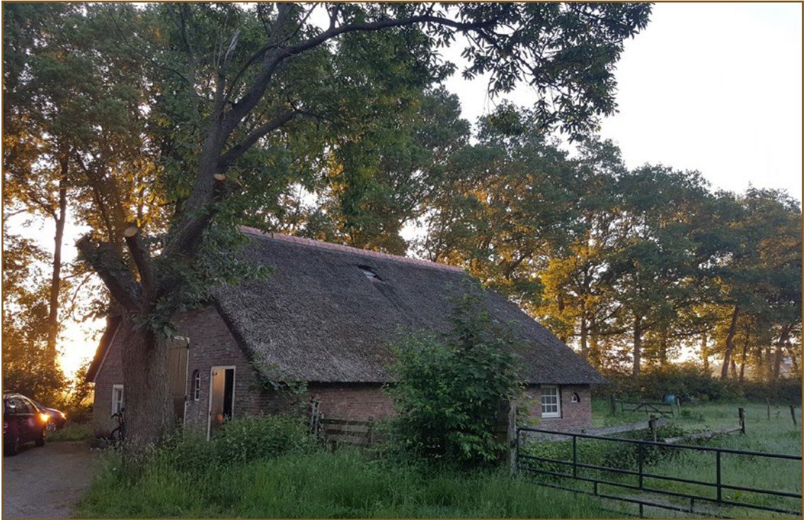
Afb. 1: De te renoveren schuur. Rondom de schuur zijn geen potentiële vaste rust- of voortplantingsplaatsen van egel aanwezig.
