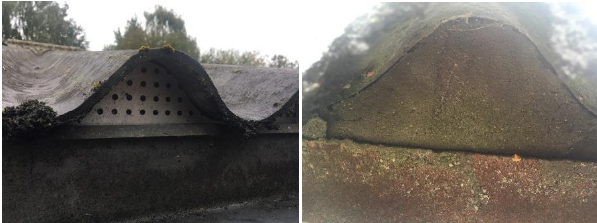
Afgedichte nokken van golfplaten verhinderen vogels om een vaste rust- voortplantingsplaats te bezetten onder de golfplaten.
