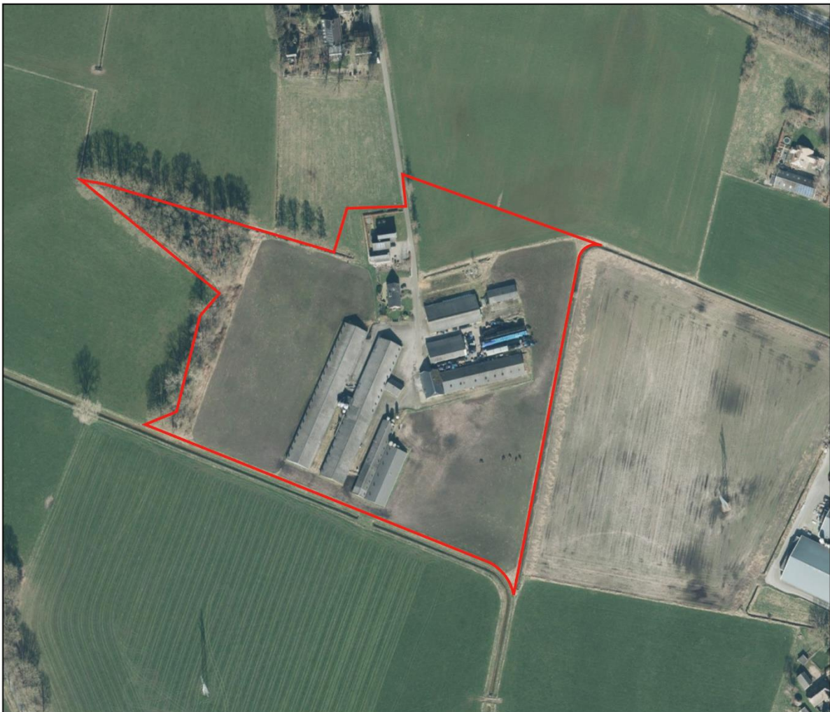
Afbeelding 2.1: Luchtfoto huidige situatie plangebied (Bron: Topotijdreis.nl)
