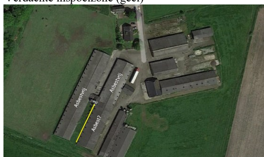
Verdachte inspoelzone (geel)
