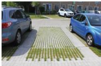
Voorbeeld van parkeren op halfverharding (grasbetonsteen)
