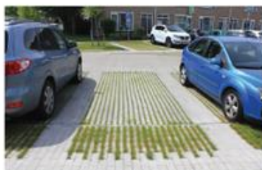
Voorbeeld van parkeren op halfverharding (grasbetonsteen)
