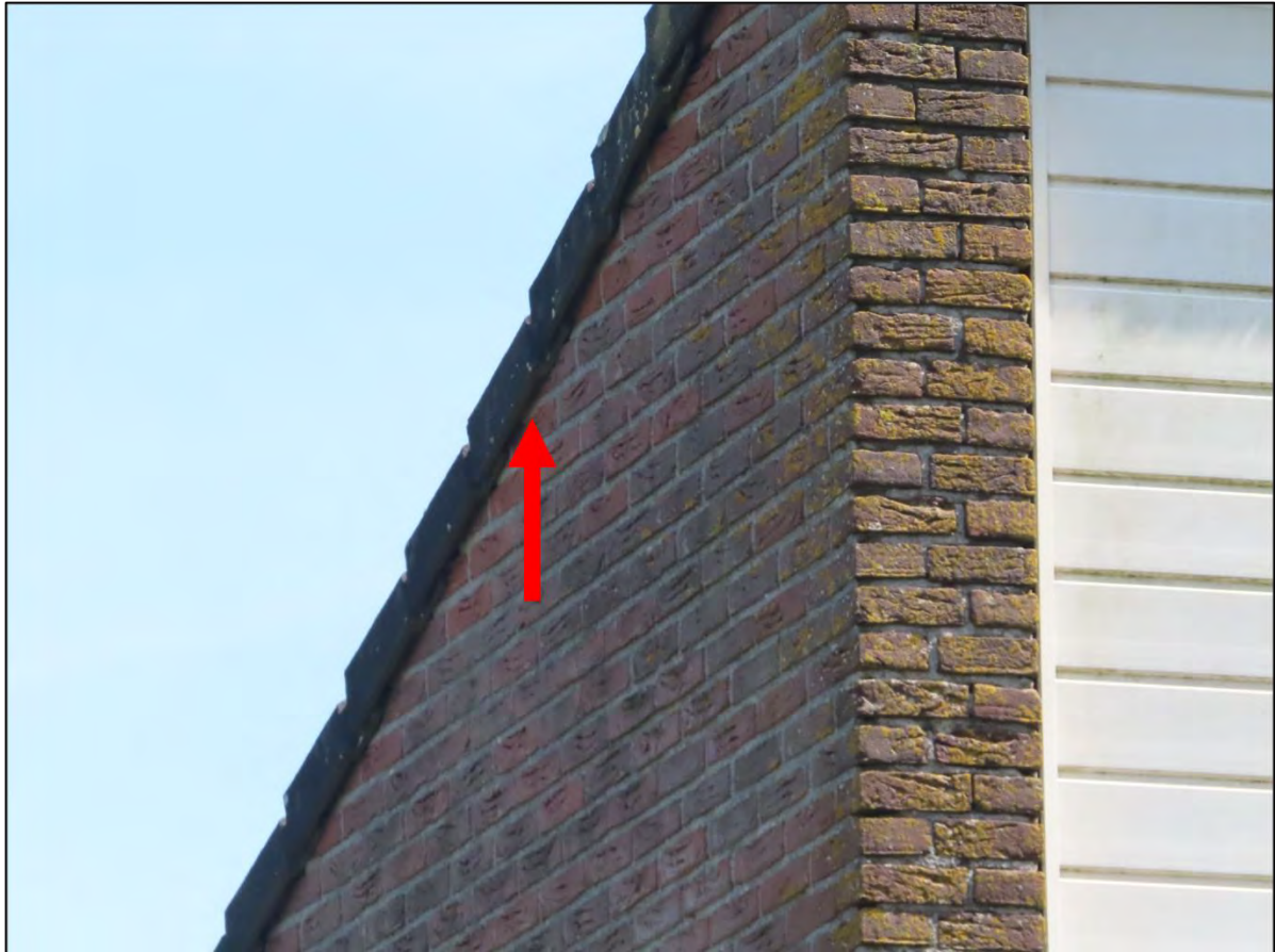
Figuur 2.4. Geschikte in- en uitvliegopeningen voor gierzwaluwen onder gevelpannen op de woning binnen deelgebied A.
