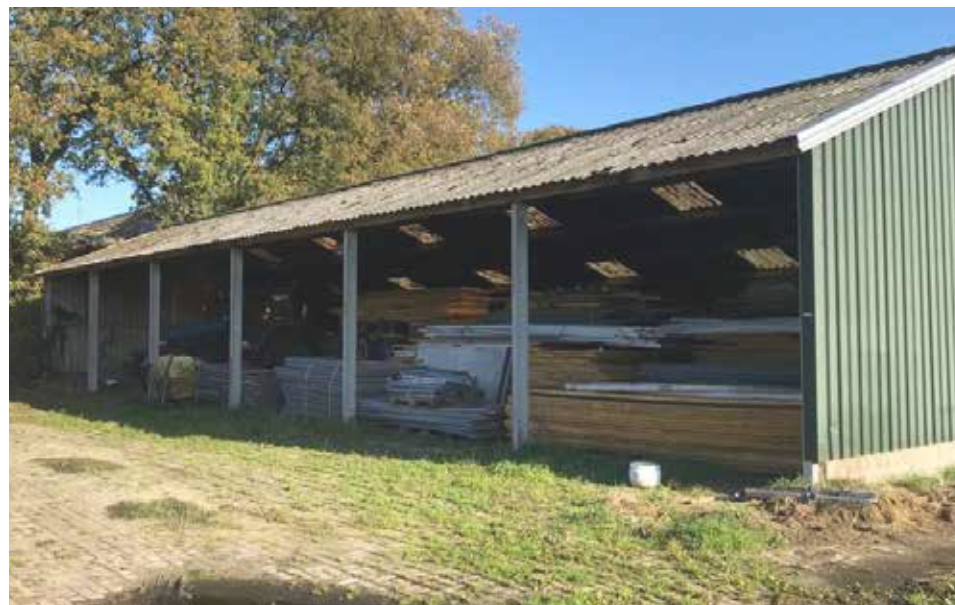
Afbeelding 11. Kapschuur voor opslag, gelegen achter de monumentale boerderij.
