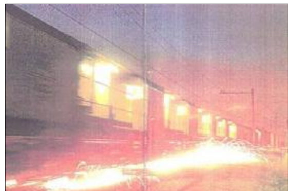
Figuur 2: Het bijlijpen van spoorstaven
