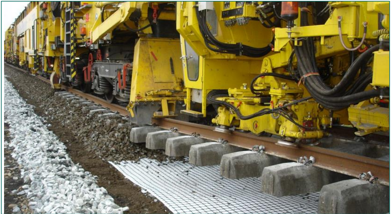
Figuur 21: Voorbeeld aanbrengen nieuw ballast in combinatie met geotextiel (Bron: De Stentor april 2017)).
