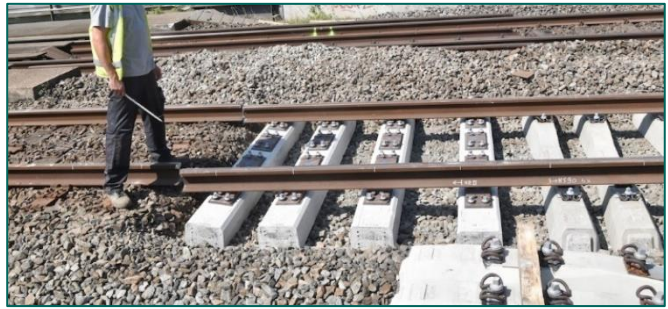
Figuur 19: vervangen bielzen voor betonnen dwarsliggers (Bron: https://www.deorkaan.nl/werk-aan-het-spoor-zaanlijn-zonder-houten-bielzen ).
