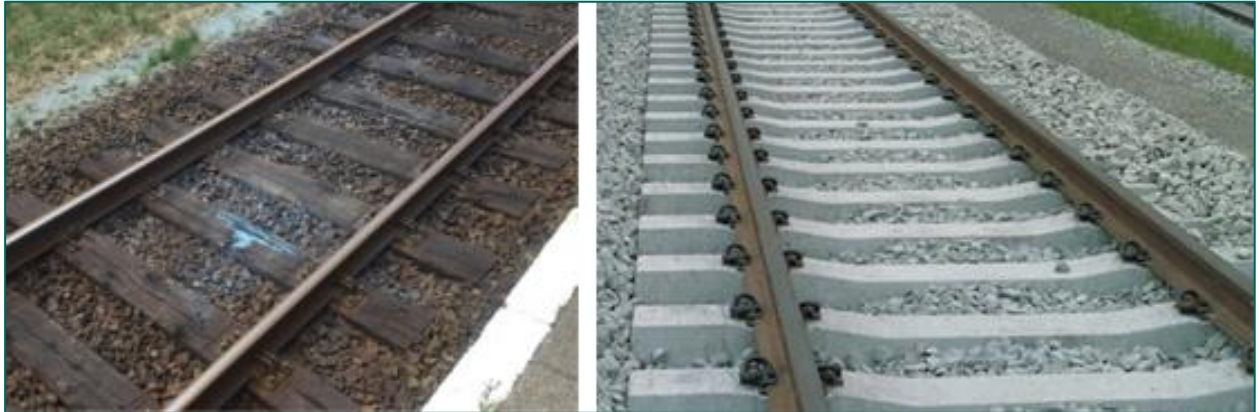
Figuur 27: Dwarsliggers, links bielzen, rechts beton Bron: REASeuro-database).
