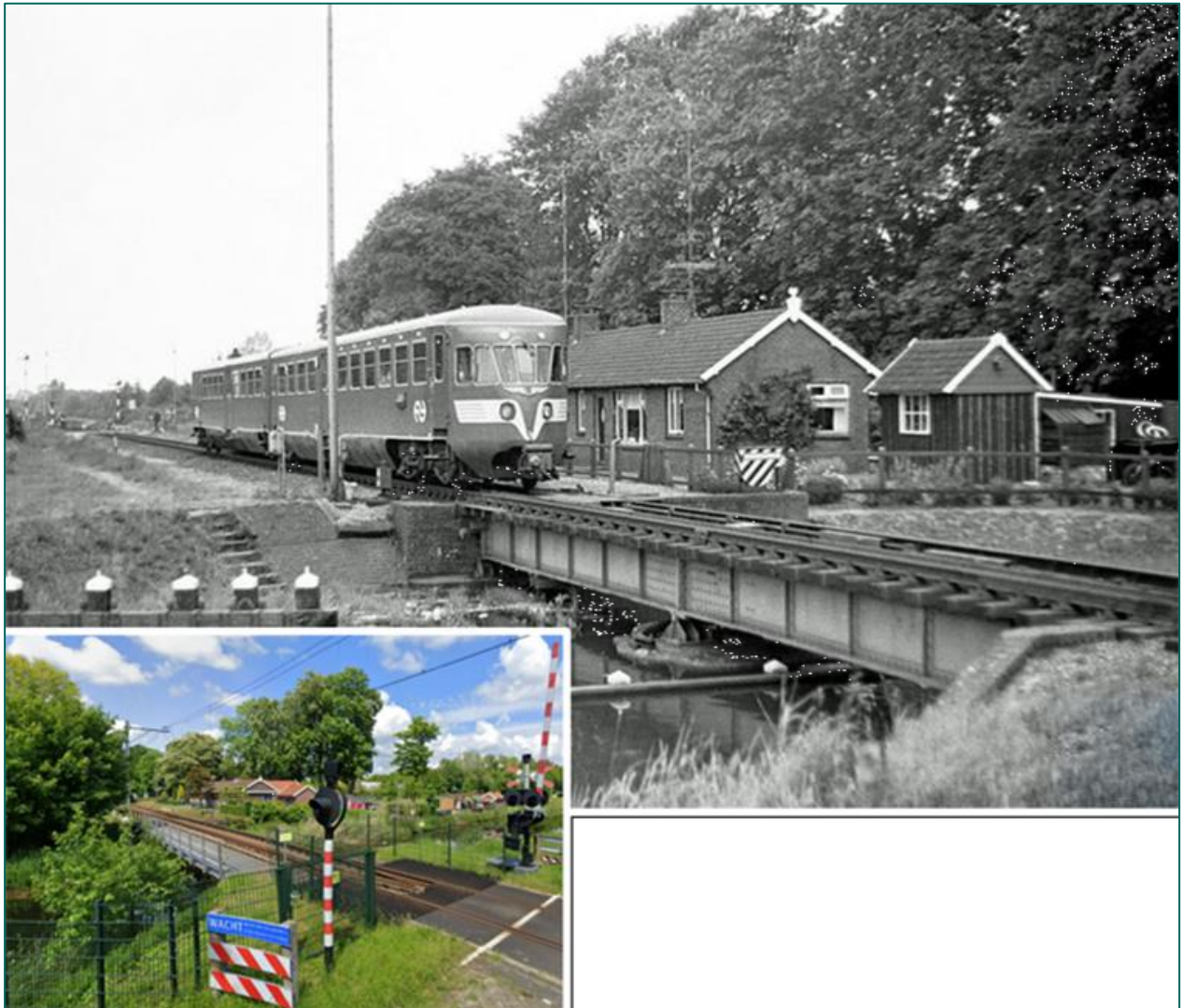
Figuur 35: De draaibrug over het Overijsselskanaal met treinstel NS DE2 72 van Zwolle naar Enschede. (Bron: www.klassiekebeveiliging.com - Foto: R. Ankersmit). De draaibrug werd later vervangen door een vaste brug (zie linksonder – Bron: Google Maps).
