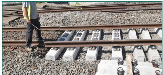
Figuur 28: vervangen bielzen voor betonnen dwarsliggers.
