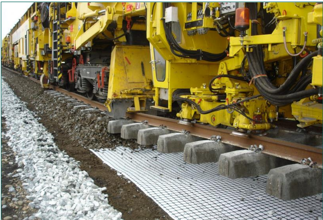
Figuur 30: Voorbeeld aanbrengen nieuw ballast in combinatie met geotextiel.
