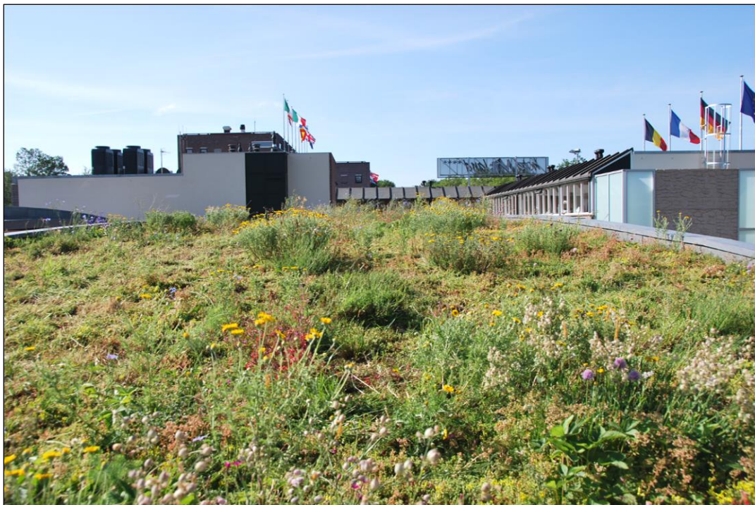
Figuur 5.11 Voorbeeld van een groen dak van Sempergreen.
