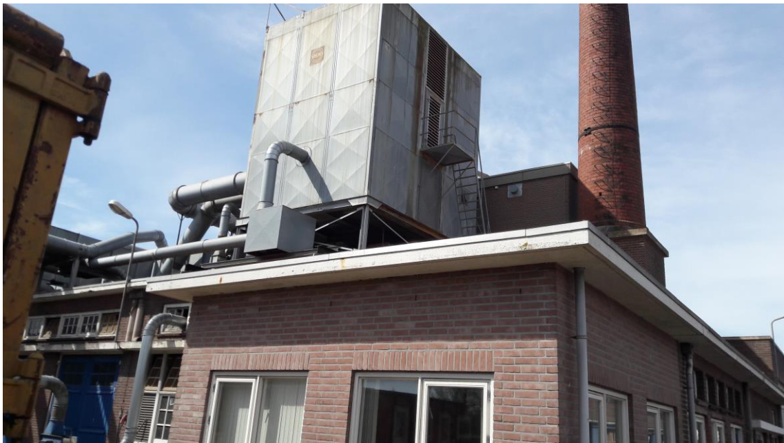
Figuur B4 De schoorsteen en een fabrieksgebouw met open stootvoegen. Foto: Mark Hoksberg.
