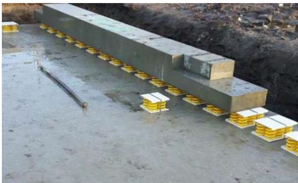
Figuur 21 Dubbele fundering met stalen veerdozen (project in Prinsenbeek)
