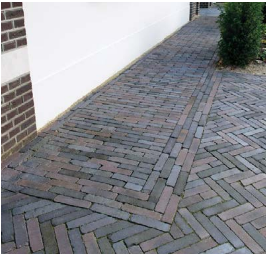
Klinkers in keperverband op het erf en plint in halfsteensverband langs gevel
