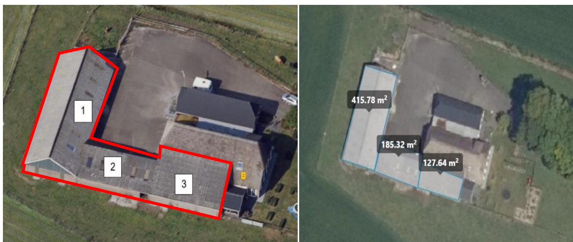
Figuur 8 Te slopen landschapontsierende bebouwing (rood omkaderd) aan de Voorhorsterweg 2 te Heeten met afmetingen, totaal circa 718 m 2 (Bron: PDOK).
