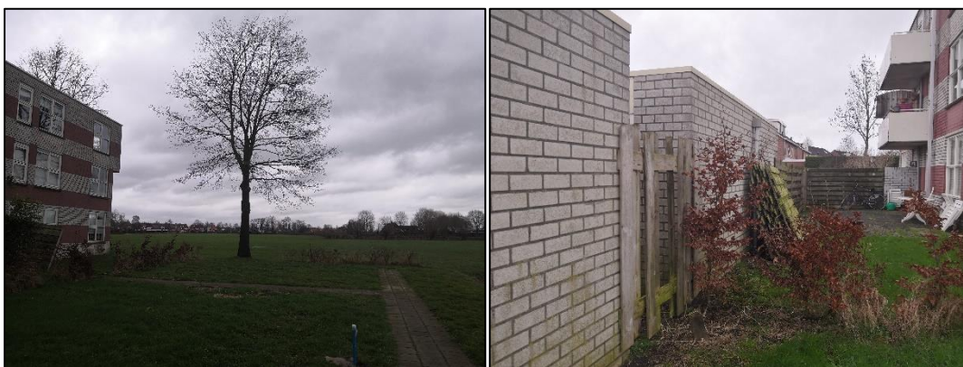
Figuur 2.7 (links) Het parkje ten oosten van het appartementencomplex met daarin een boom;; Figuur 2.8 (rechts): De achterzijde van de schuren, hier staat een slecht onderhouden haag en een schutting.
