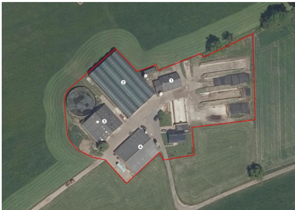
Figuur 2. Huidige terreinsituatie met plangrens (rood) en gebouwnummers.
