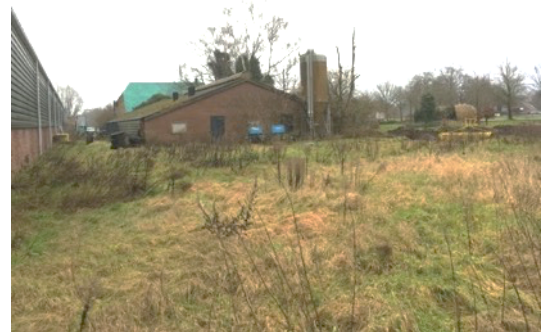
Figuur 7. Gebouw nr. 5 met links gebouw nr. 1.
