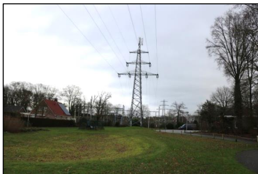
Figuur 4.10. Mast 43 en locatie open ontgraving.
