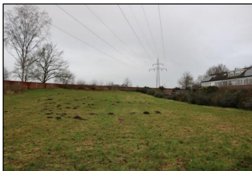
Figuur 4.4. Uittredepunt eerste HDD-boring ter hoogte van de Maten.
