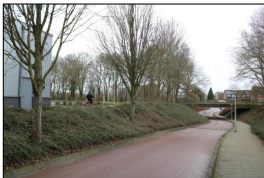
Figuur 4.14. Locatie derde HDD-boring.
