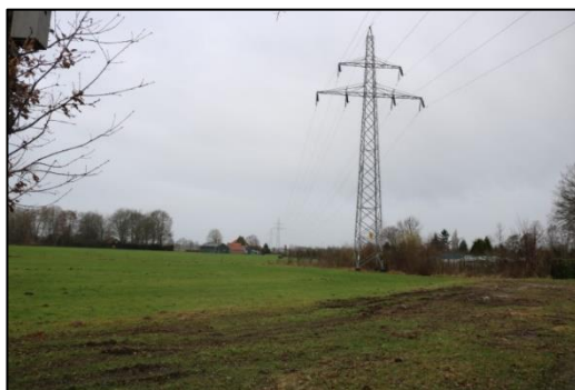
Figuur 4.2. Mast 40 en locatie intredepunt eerste HDD-boring (westzijde van Raalte).
