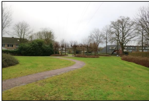
Figuur 4.6. Intredepunt tweede HDD-boring.
