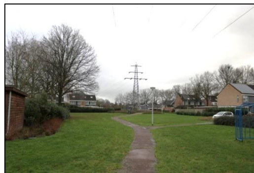
Figuur 4.5. Mast 41 en locatie open ontgraving.
