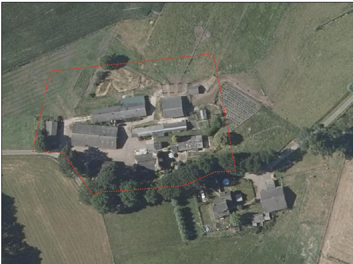
Afbeelding 2.1 Luchtfoto huidige situatie plangebied (Bron: Google maps)
