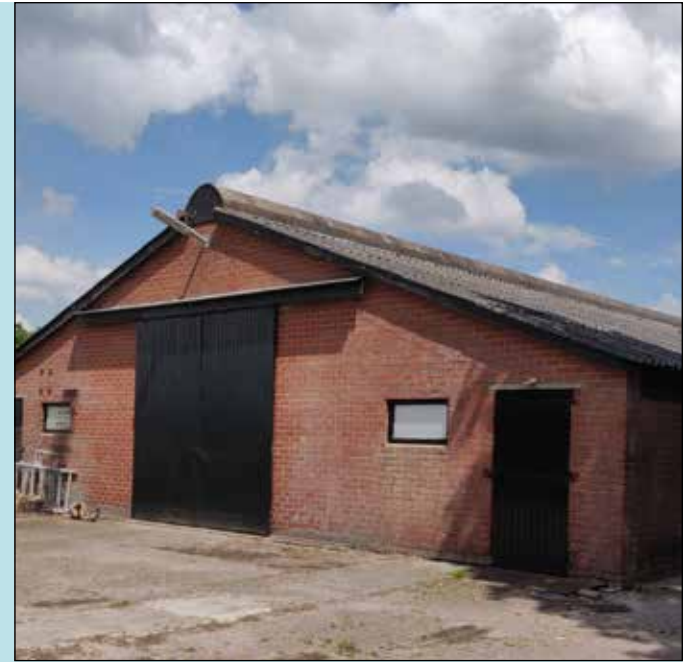
te behouden schuur (dak wordt vervangen)
