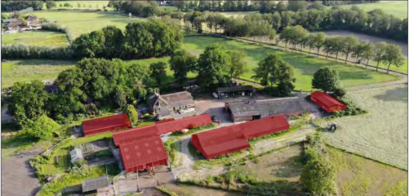
de te slopen opstallen
