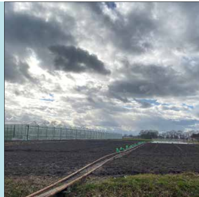
de te slopen kassen
