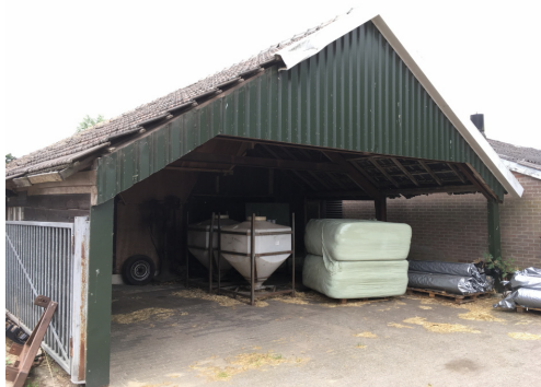
Figuur 3. Oostzijde voormalige kippenschuur
