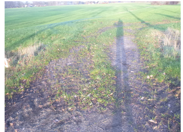
Met puin verharde inrit en dammetje
