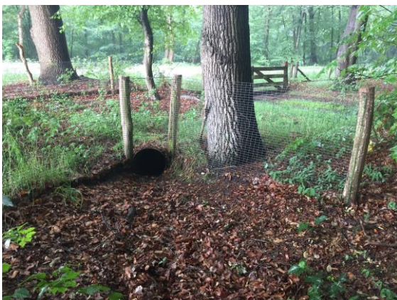
Foto 8: Dassentunnel Gunne Zuid oostzijde N35
