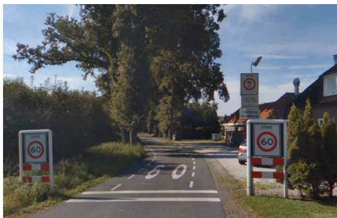
Figuur 1.1: Begin van de Schoonhetenseweg vanaf de N35
